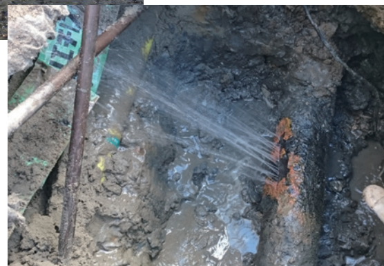
▲漏水している古い水道管
