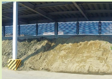
浄水場で保管
