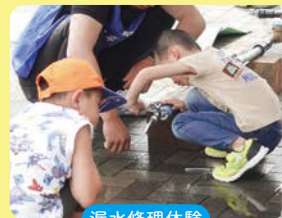
漏水修理体験
