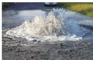
▲水道管が腐食して漏水した道路
